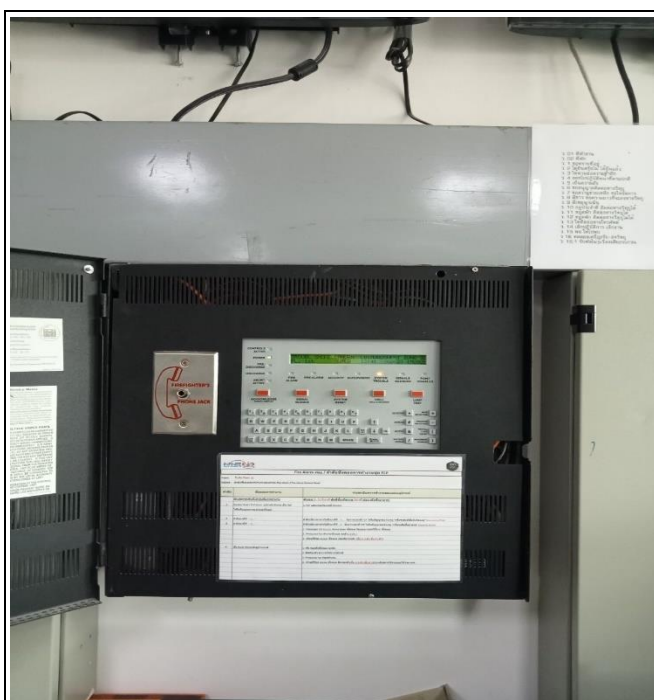
รูปที่ 2.4.6.1-2 แผงควบคุม (FCP)
