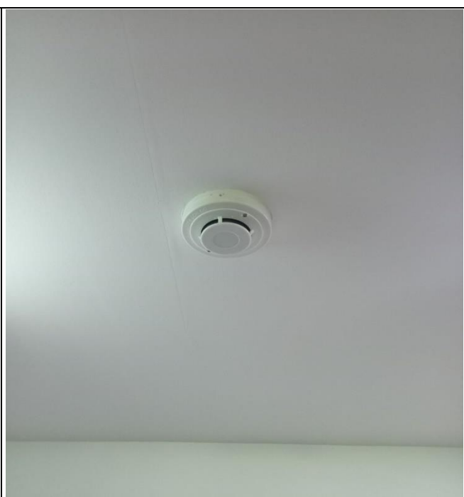
รูปที่ 2.4.6.1-2 อุปกรณ์ตรวจจับควันและความร้อน
