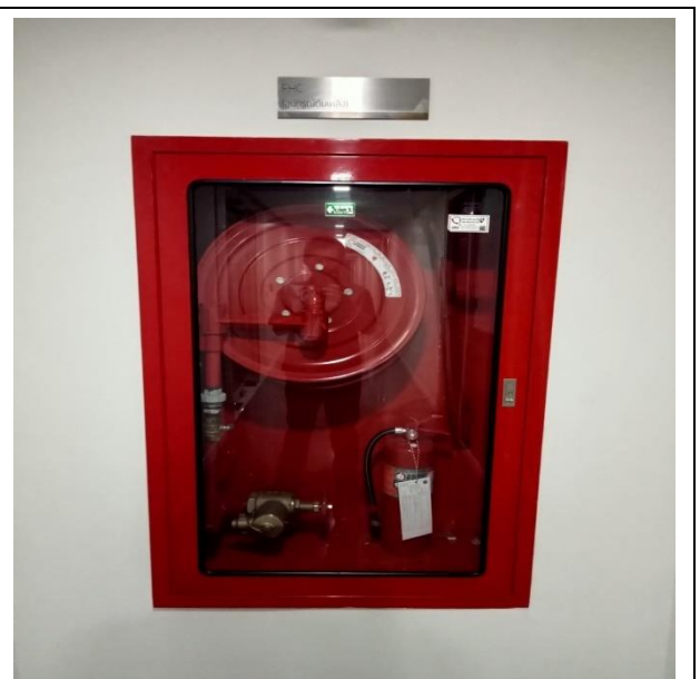
รูปที่ 2.4.6.1-2 ตู้เก็บสายน้ำดับเพลิงพร้อมอุปกรณ์
